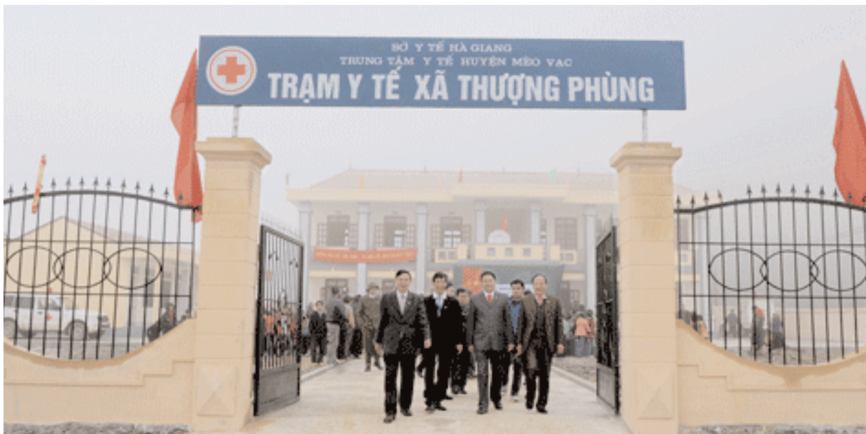
Trạm Y tế xã Thượng Phùng do Tập đoàn Vinacomin xây tặng nhân dân huyện Mèo Vạc nhân dịp Kỷ niệm 50 năm ngày thành lập Huyện
