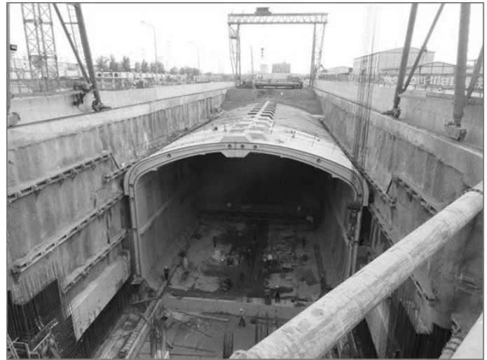
Hình 2. Hình ảnh thi công thực tế nhà ga Yuanjiadian
