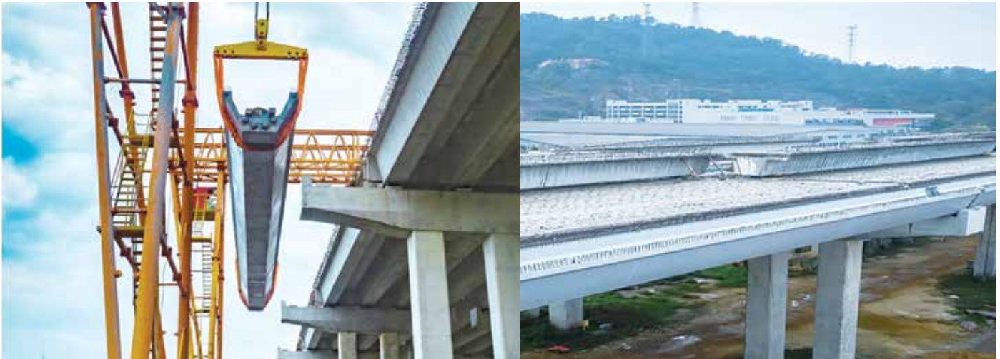
Cầu sử dụng dầm UHPC tại Trung Quốc.
