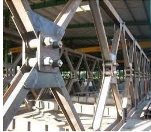
Hình 1. Liên kết bu lông trong kết cấu cầu thép
